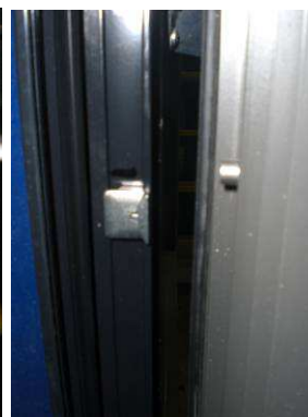
Detalle de compás, perfiles, juntas y cierres.
