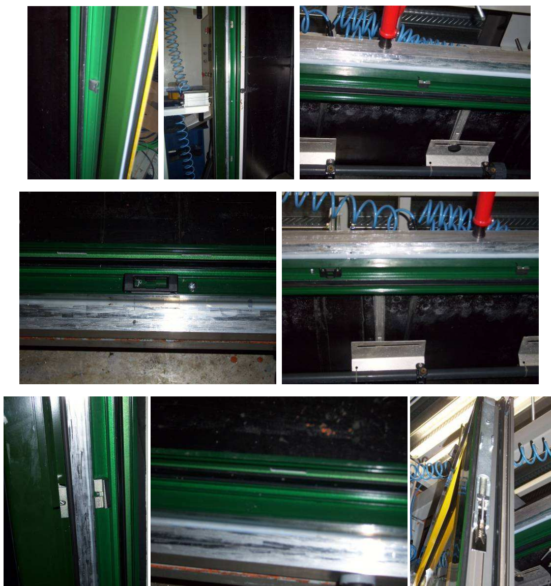
Foto N°.4. Detalle de perfiles, juntas y puntos de cierre.
