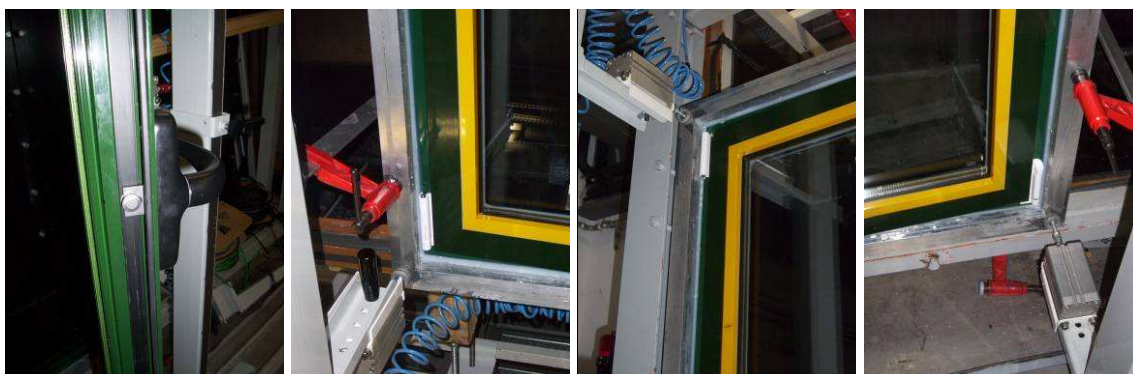
Foto N°.4. Detalle de perfiles, juntas y puntos de cierre.
