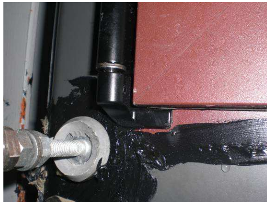
Foto N°.8. Detalle de la zona de goteo de agua.
