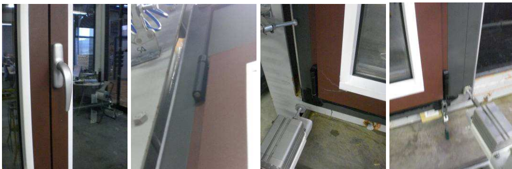
Foto N°.6. Detalle de perfiles, compás, juntas y puntos de cierre.
