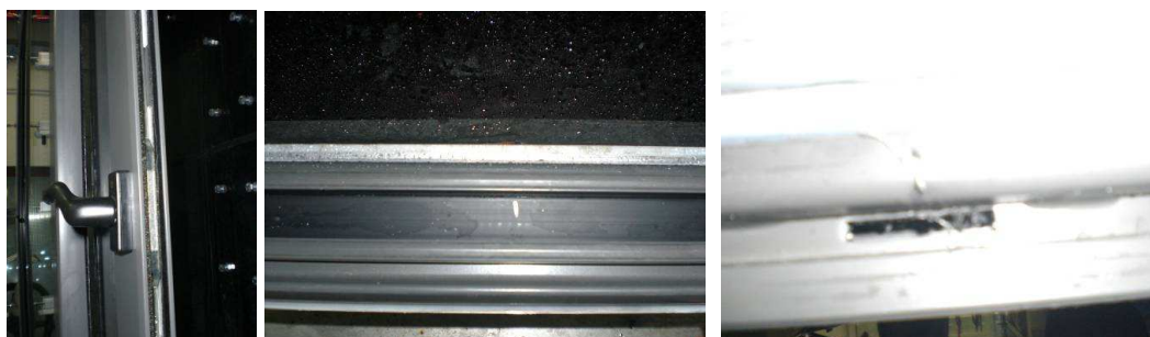
Detalle de perfil perimetral, de hoja y drenaje.
