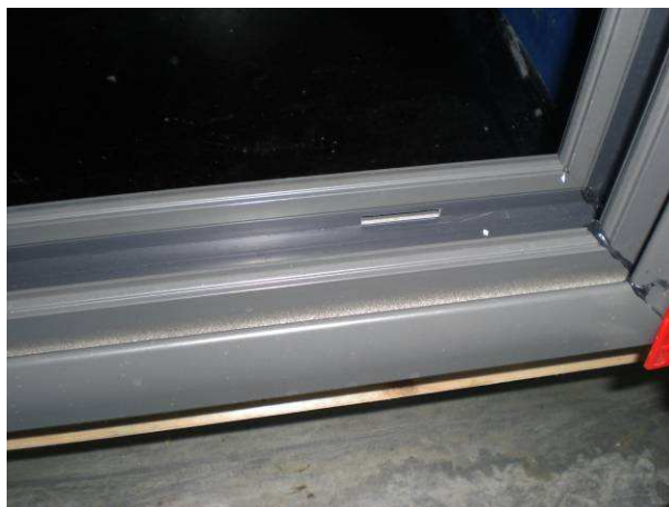
Foto N°.4. Detalle de drenaje y perfil perimetral.
