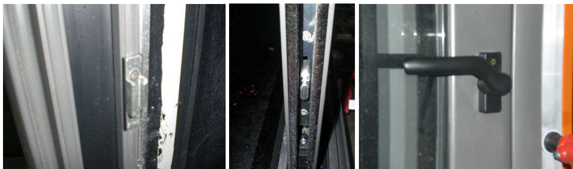
Foto N°.3. Detalle de manilla y puntos de cierre.
