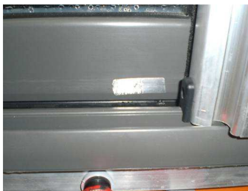
Foto N°.4. Detalle de las zonas de goteo de agua.
