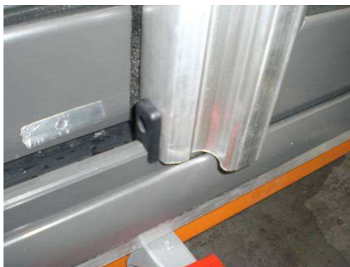
Detalle de cruce de hojas y perfiles inferior de hoja y refuerzo.
