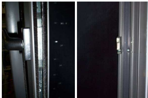
Foto N°.3. Detalle de manilla y punto de cierre.
