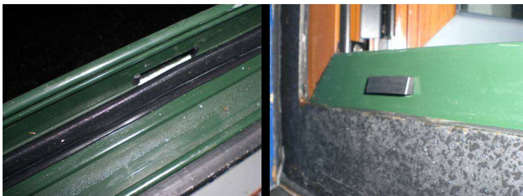
Foto N°.5. Detalle de junta y drenaje.
