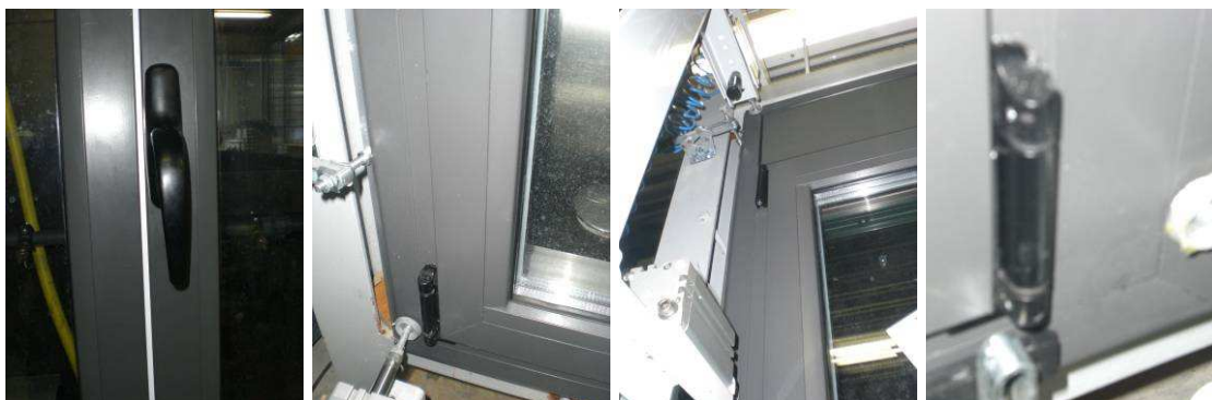
Foto N°.5. Detalle de manilla y bisagras.
