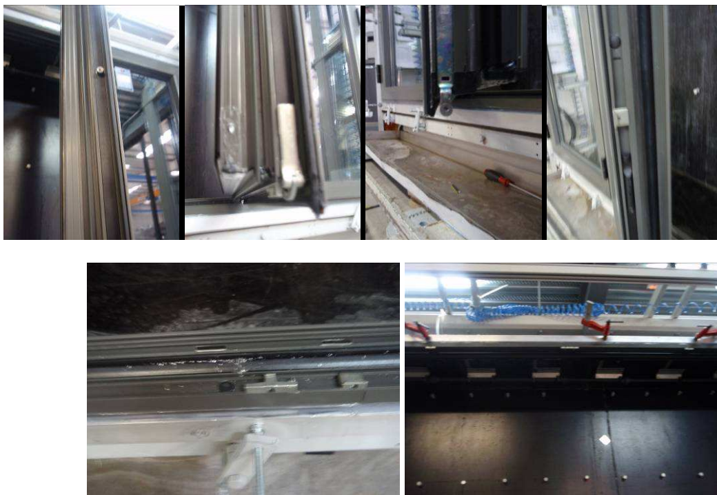
Foto N°.3. Detalle de cierres, perfiles y juntas.
