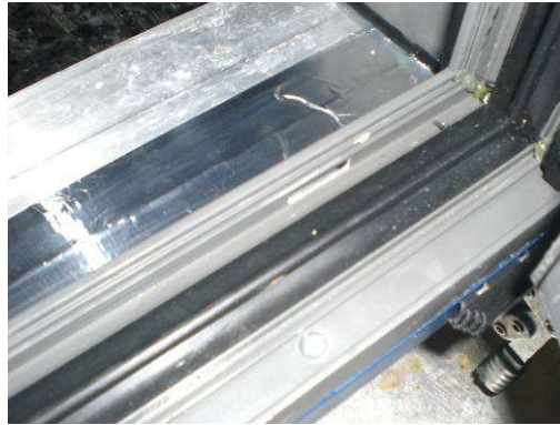
Foto N°.7. Detalle de perfil inferior, junta y drenaje.
