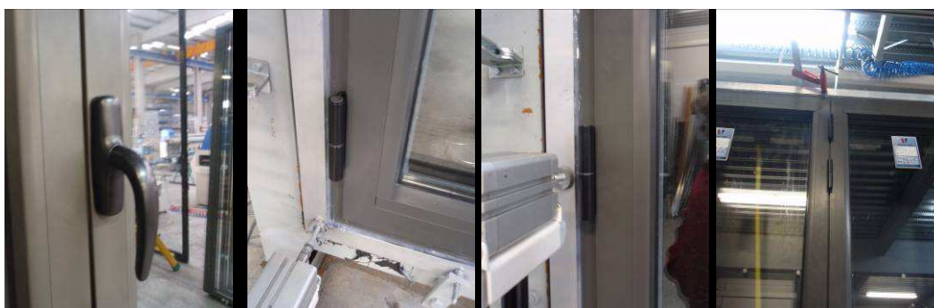
Foto N°.2. Detalle de manilla, y bisagras.
